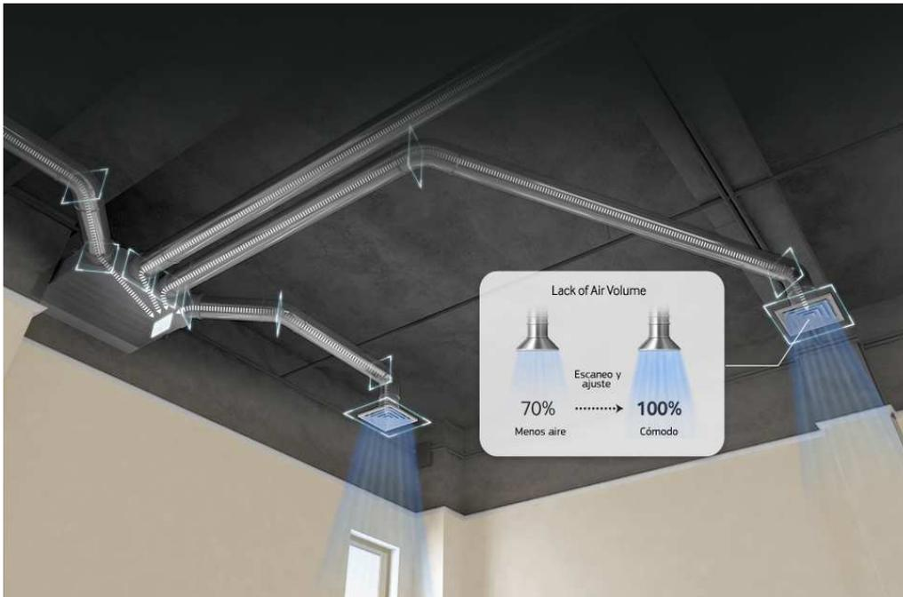
Los Conductos Deluxe detectan la presión y el volumen de aire instantáneamente para ajustarlo rápidamente y así garantizar un confort óptimo, sin importar la longitud de los tubos. Así, disfrutaras de un mejor rendimiento y con más silencio. Además, podrás ajustar fácilmente la presión mediante el mando a distancia.
